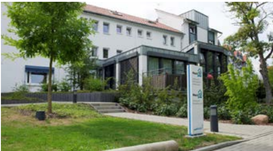
Klinikgebäude Privat-Nervenlinik Dr. med. Fontheim
